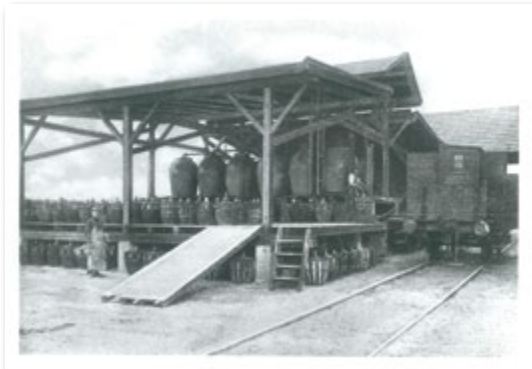
Teil der Säurespeicheranlagen der Firma Theo Seulberger
